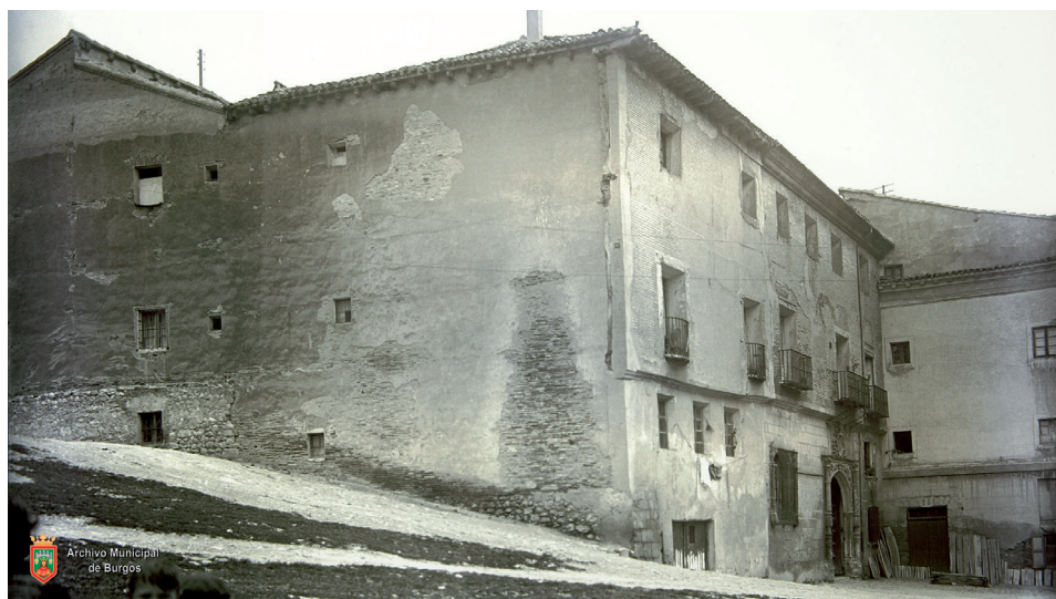
Fig. 4. Palacio de Castilfalé antes de la restauración realizada en 1919. AMBu. ID-50422.
