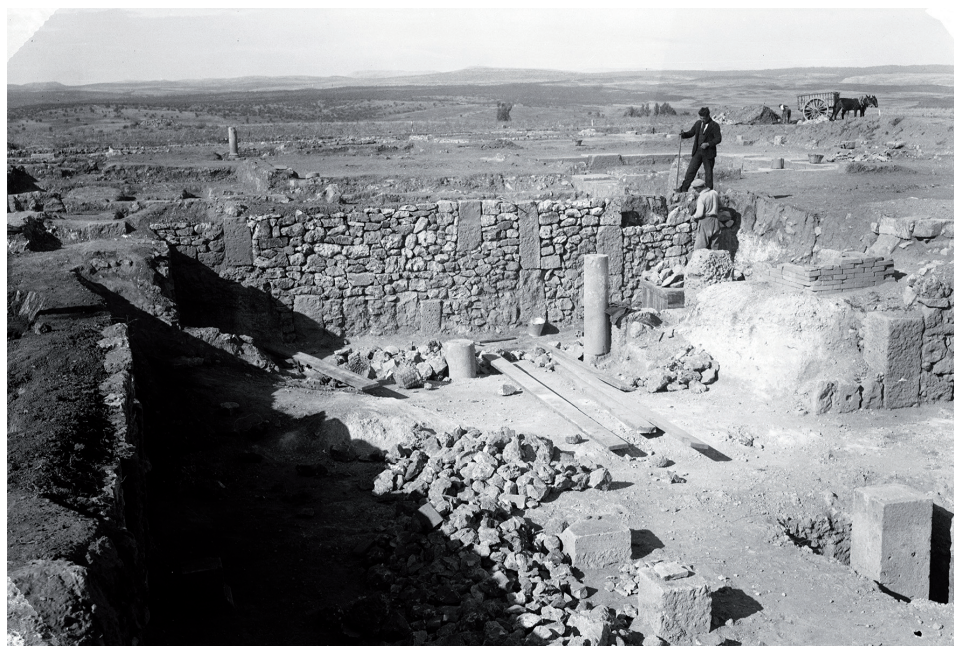
Fig. 5. Clunia. Vista de la habitación 59 de “las Erillas”, tras la consolidación de sus muros en 1935.
