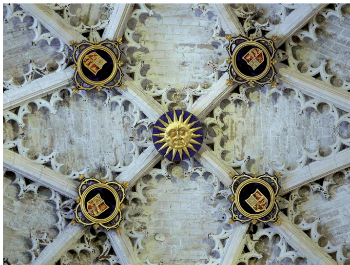
Fig. 14. Representación del sol en el pinjante de la clave central de la bóveda principal de la capilla de la Concepción.
