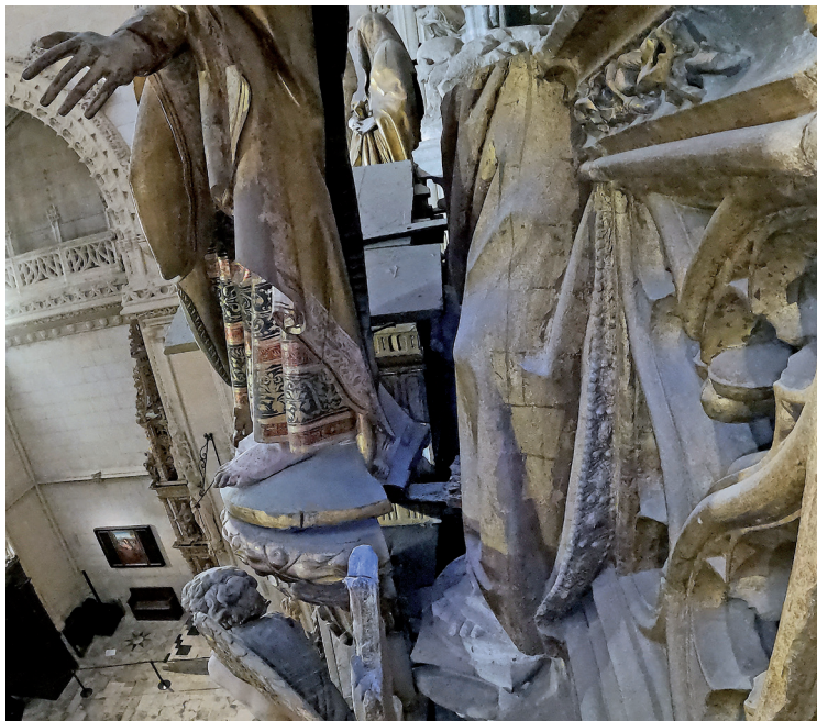
Fig. 32. A la derecha de la imagen se puede ver la figura del san Juan del calvario tardogótico seccionada a la altura del pasamanos del antepecho del triforio. Delante de ella, su “sustituta” renacentista
